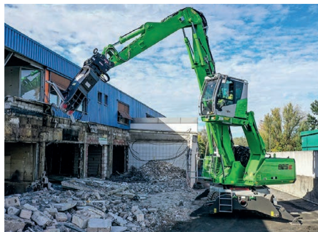
Les configurations d'équipements sont multiples et variées (pied, flèches, rallonges, balancier) pour obtenir une combinaison parfaite sur site. Les pelles sont quasiment toutes munies d'une trains de chaînes à voie variable, à l'exception d'une Sennebogen sur roues.
