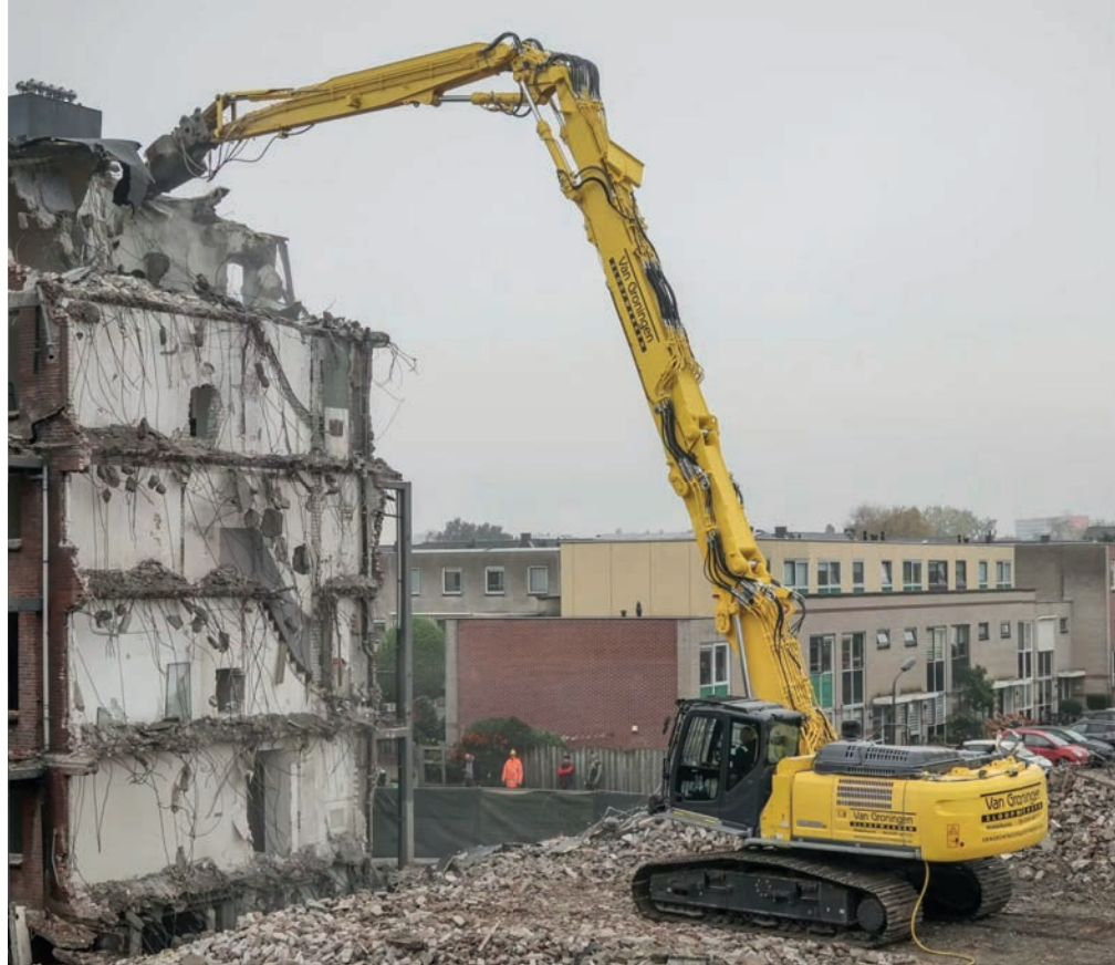
Les configurations d'équipements sont multiples et variées (pied, flèches, rallonges, balancier) pour obtenir une combinaison parfaite sur site. Les pelles sont quasiment toutes munies d'une trains de chaînes à voie variable, à l'exception d'une Sennebogen sur roues.
