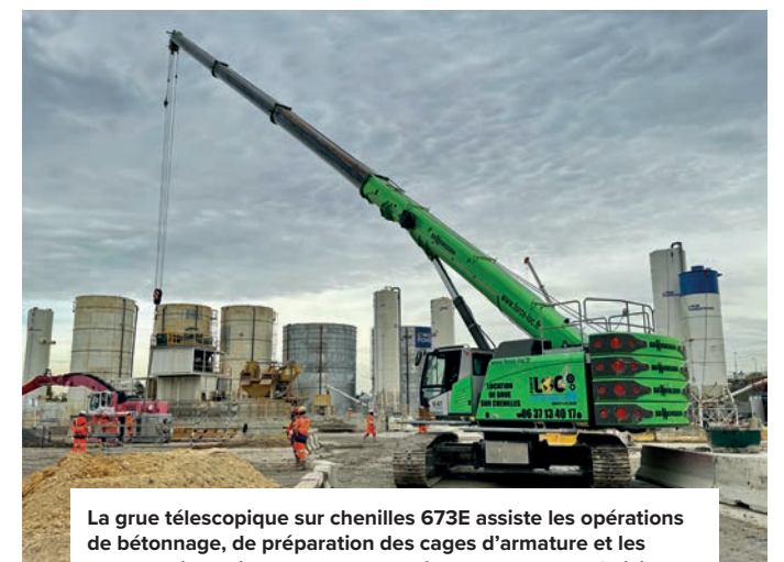
La 3300 de l'entreprise Force-Loc assure les mises en place de cages d'armature sur le chantier de lancement du tunnelier « Les Caboeufs »
