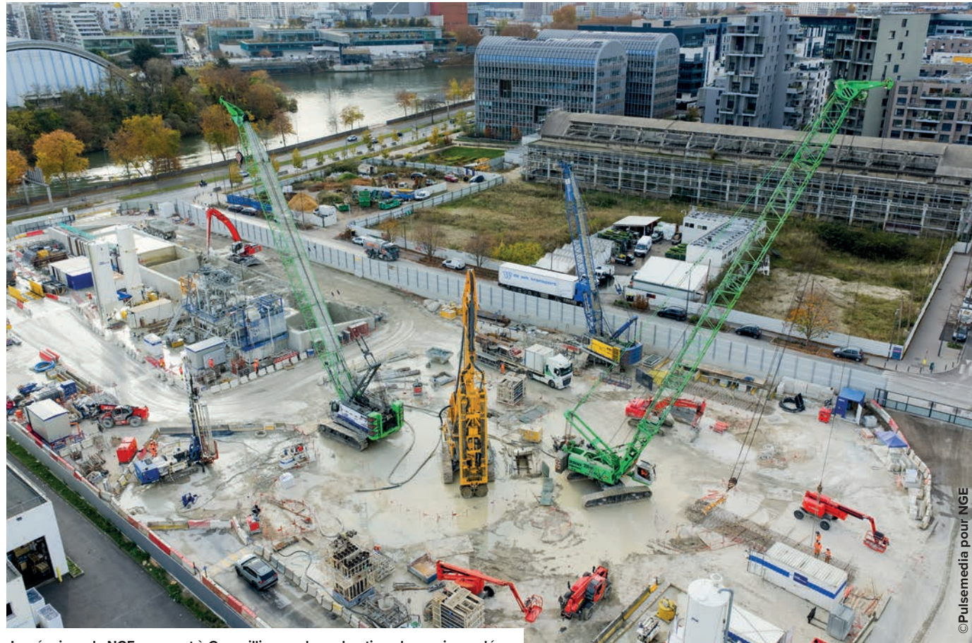
Les équipes de NGE oeuvrent à Genevillier sur deux chantiers de parois moulées.
