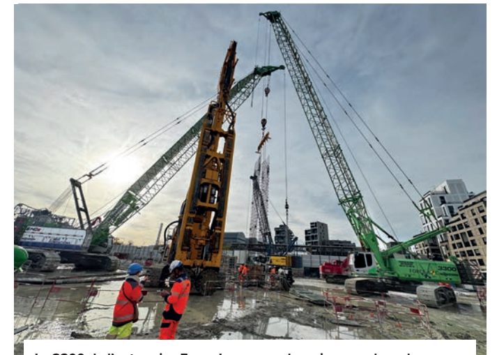
La 3300 de l'entreprise Force-Loc assure les mises en place de cages d'armature sur le chantier de lancement du tunnelier « Les Caboeufs »
