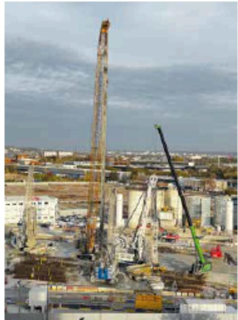
La grue sur chenilles Sennebogen 3300 de l'entreprise Force-Loc assure les mises en place de cages d'armature sur le chantier de lancement du tunnelier « Les Caboeufs » à Gennevilliers.
