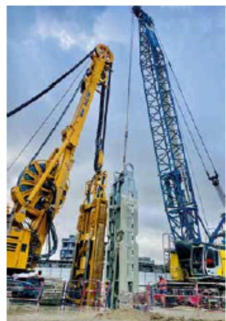
En face à face une pelle à câble en excavation benne à parois, et une hydro-haveuse qui excavé et qui bétonne en même temps.
