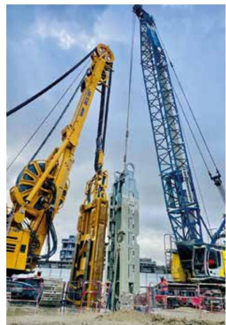
En face à face une pelle à câble en excavation benne à parois, et une hydro-haveuse qui excave et qui bétonne en même temps.
